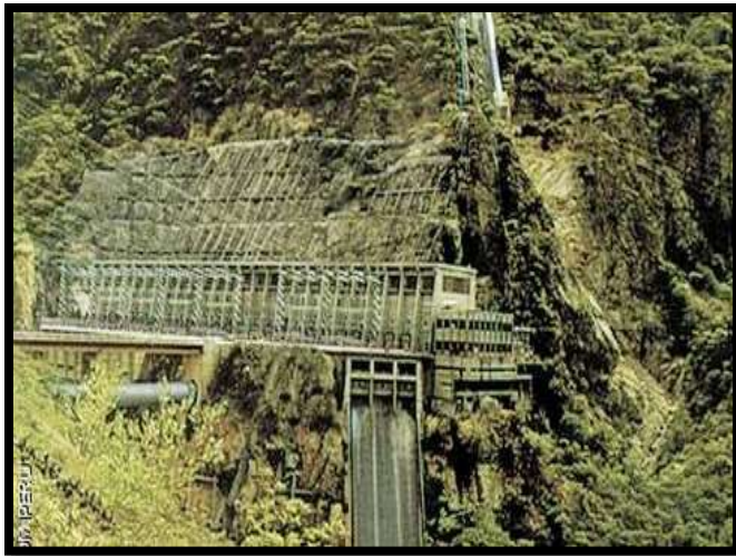
Figura N° 4: La central eléctrica Restitución
