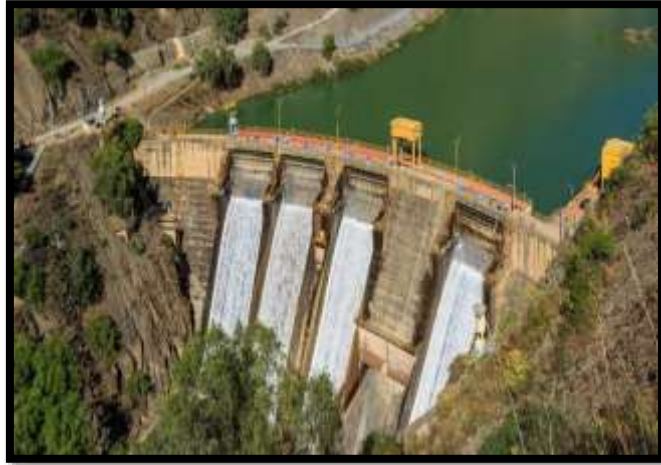
Figura N°3: Central eléctrica de Santiago Antúnez de Mayolo (SAM)
